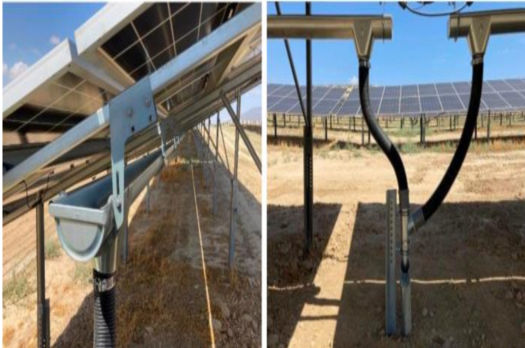
Abbildung 38: Details RWH-System in der APV-Anlage in Alhéndin, Südspanien (Bousi 2024).
