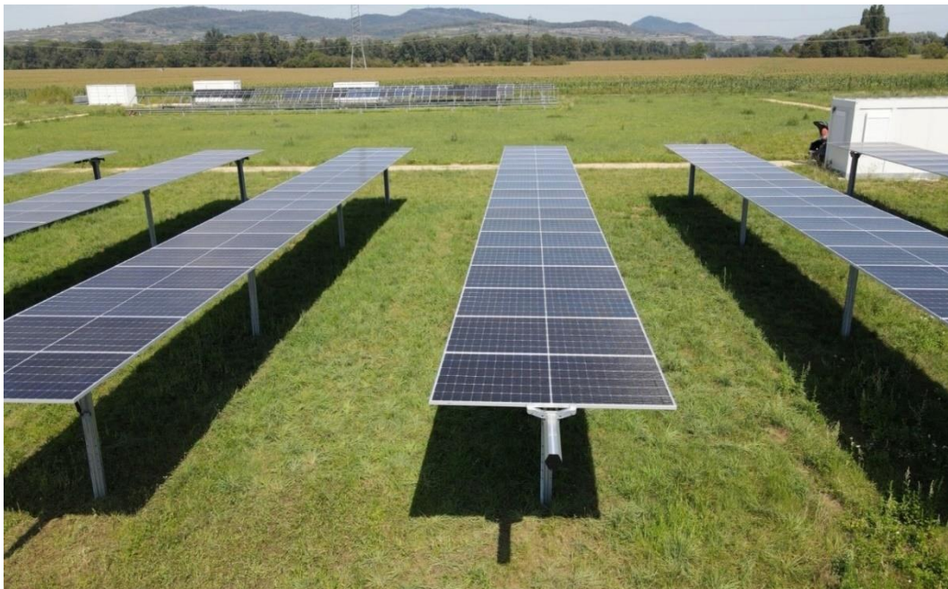
Abbildung 26: APV-Anlage mit einem Tracking-System. Die PV-Module der nachgeführten PV-Anlage der Zimmermann Tracker GmbH auf dem Outdoor Performance Testfeld des Fraunhofer ISE in Merdingen. Tracker sind für die landwirtschaftliche Nutzung zwischen den Modulreihen niedrig aufgeständert (Fraunhofer ISE 2024a).
