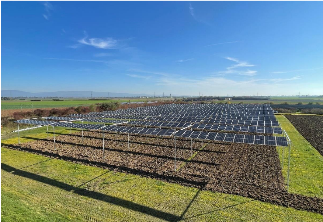
Abbildung 27: Seilaufhängung im Rahmen des APV-Projekts „HyPERFarm“ in Straßkirchen (Krinner Carport GmbH 2022).
