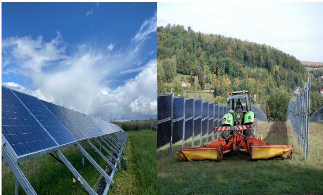
Abbildung 25: Bodennahe APV-Anlage im Ackerbau (links). Vertikale APV-Anlage im Ackerbau (rechts). Diese Systeme zeichnen sich durch vereinfachte Tragstrukturen mit reduzierten Materialkosten und geringeren Windlastberechnungen im Vergleich zu hoch aufgeständerten Systemen aus (Zahrawi und Aly 2024).
