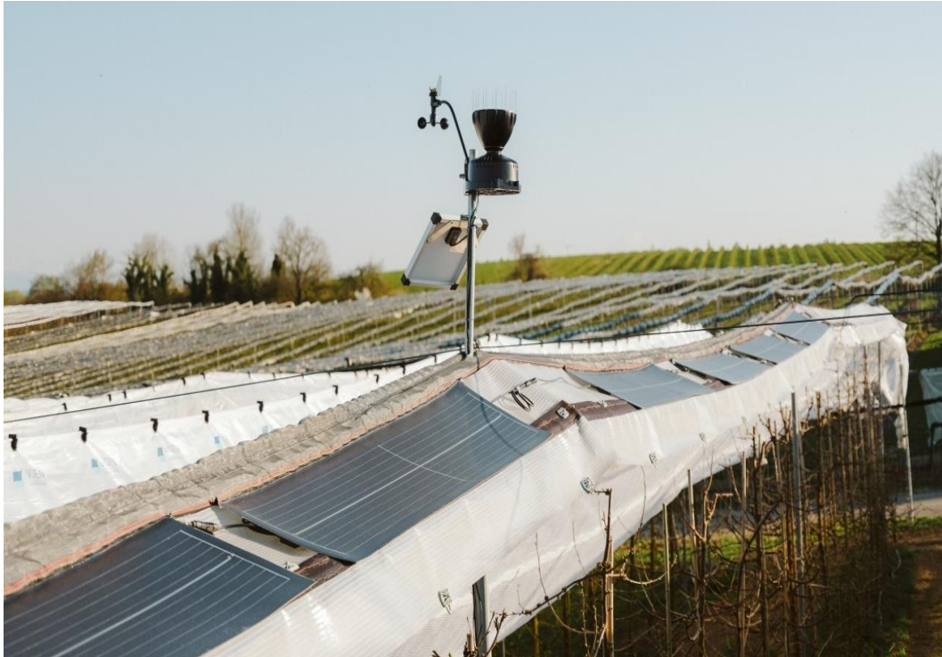
Abbildung 30: Leichte PV-Module. Das Fraunhofer ISE und die Firma VOEN Vöh-ringer GmbH & Co. KG haben besonders leichte PV-Module entwickelt, die sich problemlos auf gängigen Wetterschutzsystemen für Sonderkulturen installieren lassen (Fraunhofer ISE 2025).
