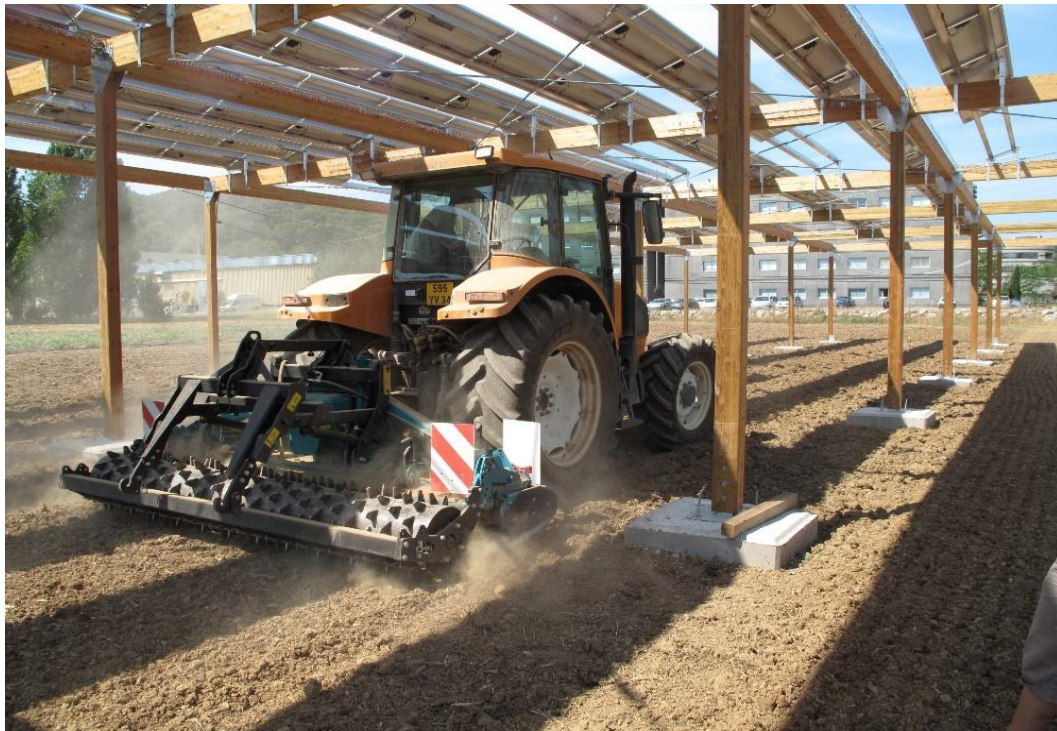
Abbildung 28: APV-Anlage mit tragender Unterkonstruktion aus behandeltem Holz (Marrou 2019).
