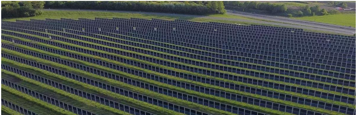
Abbildung 10 Solarpark in Donaueschingen-Aasen (PV Netzwerk Baden-Württemberg, 2024)
