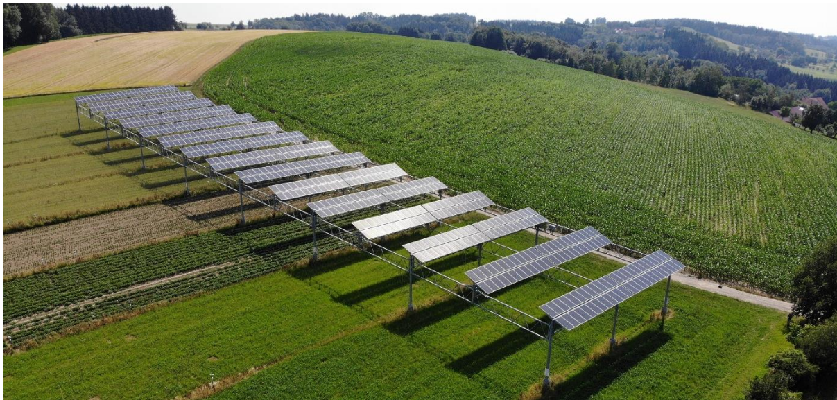
Abbildung 7 APV Anlage in Heggelbach Baden-Württemberg (Fraunhofer ISE 2025)
